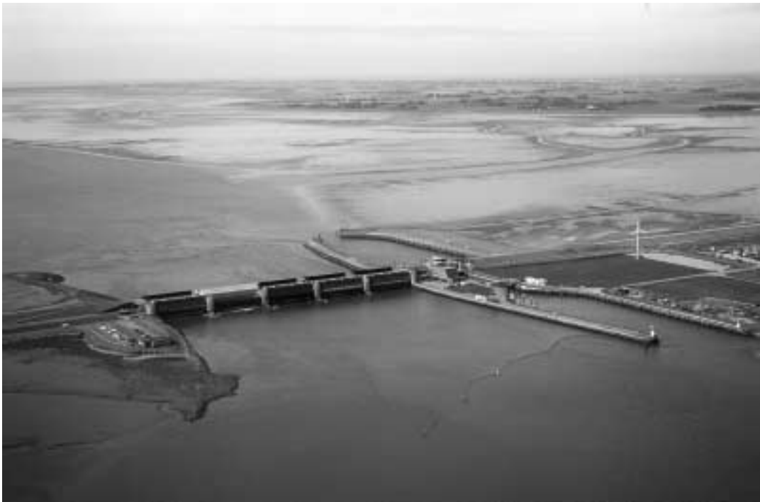
Abbildung 2: Blick von Süd-Ost auf das Eidersperrwerk bei Niedrigwasser. Erkennbar ist das Sielbauwerk mit fünf Wehrtoren und die Schiffahrtsschleuse mit den see- und binnenseitigen Vorhäfen. Seeseitig schließen sich die Wattflächen der Außeneider an. (Photo von Norbert Kempf, 1997)
